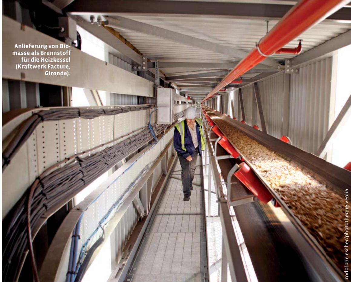
Anlieferung von Biomasse als Brennstoff für die Heizkessel (Kraftwerk Factice, Gironde).
