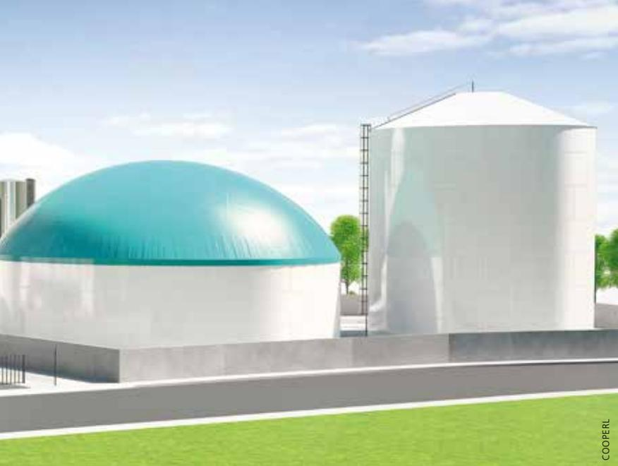
*L'installation de la Cooperl est gigantesque : deux digesteurs de 5 000 m<sup>3</sup> (18 m de diamètre sur 22 m de haut), un post-digesteur, une épuration membranaire. C'est le plus gros poste d'injection sur le réseau GRDF en France.*
