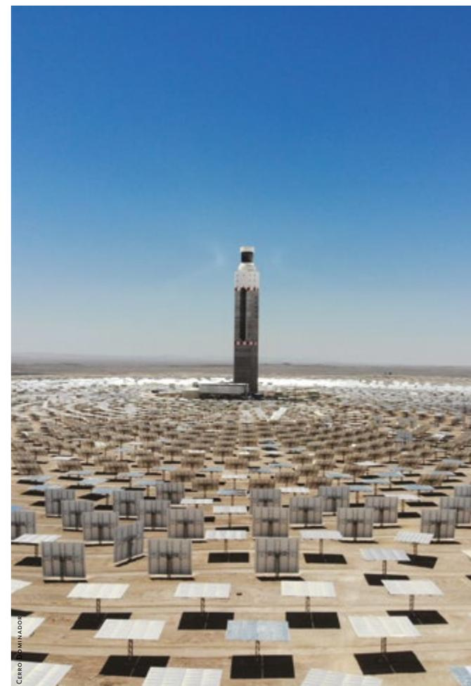
fondus qui circulent dans le récepteur peuvent atteindre des températures de plus de 560 °C. Stockés dans de larges tanks, ils peuvent être utilisés ultérieurement et produire de l'électricité grâce à une turbine à vapeur. Ce projet installé à l'autre bout du monde a obtenu des financements du programme Laif de l'Union européenne et de la banque de développement allemande KfW. Il a été construit par un consortium formé par Acciona-Abengoa.
