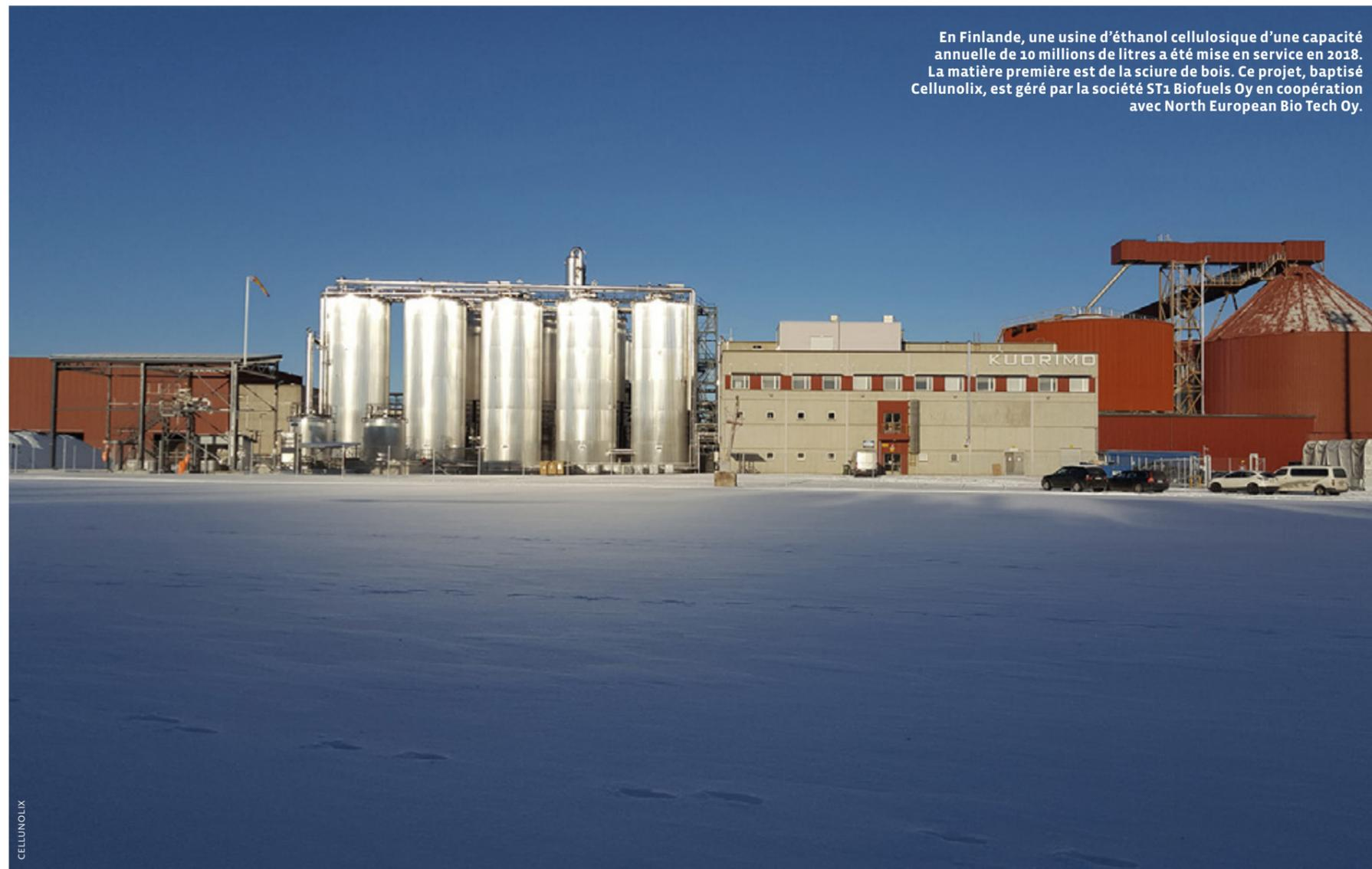
En Finlande, une usine d'éthanol cellulosique d'une capacité annuelle de 10 millions de litres a été mise en service en 2018. La matière première est de la sciure de bois. Ce projet, baptisé Cellunolix, est géré par la société ST1 Biofuels Oy en coopération avec North European Bio Tech Oy.
