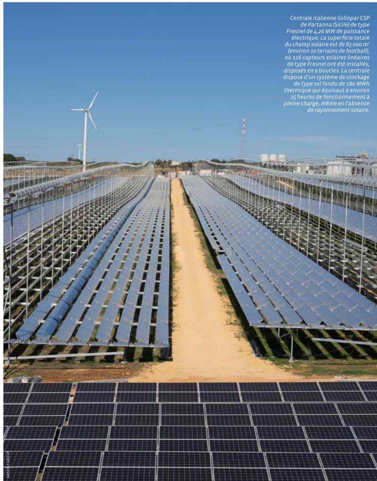
Centrale italienne Solinpar CSP de Partanna (Sicile) de type Fresnel de 4,26 MW de puissance électrique. La superficie totale du champ solaire est de 83 000 m<sup>2</sup> (environ 10 terrains de football), où 126 capteurs solaires linéaires de type Fresnel ont été installés, disposés en 9 boucles. La centrale dispose d'un système de stockage de type sel fondu de 180 MWh thermique qui équivaut à environ 15 heures de fonctionnement à pleine charge, même en l'absence de rayonnement solaire.
