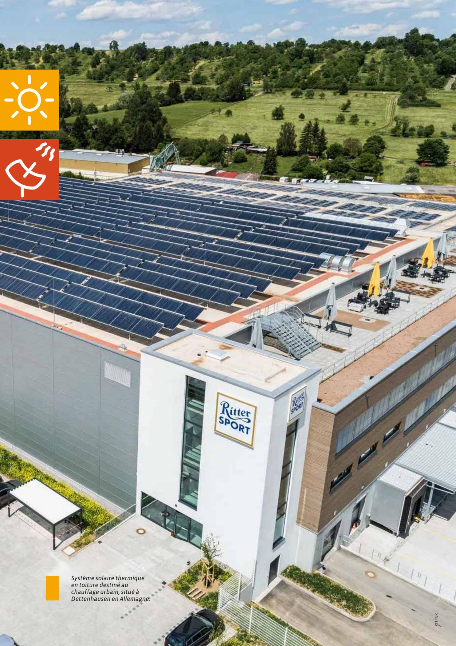
Système solaire thermique en toiture destiné au chauffage urbain, situé à Dettenhausen en Allemagne.
