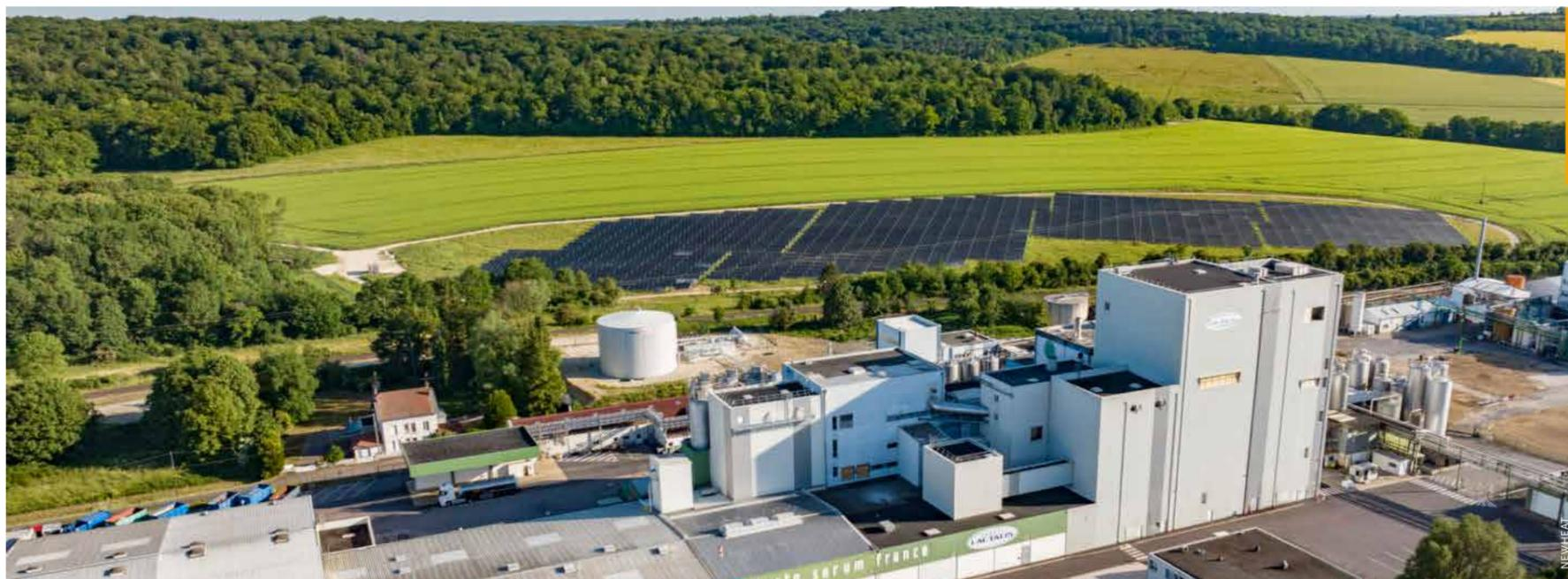
La centrale de l'usine de poudre de lactosérum du groupe français Lactalis, à Fromeréville-les-Vallons, près de Verdun. Équipée d'une surface de capteurs solaires thermiques de 15 300 m<sup>2</sup>, soit une puissance solaire de 14 MWth, elle dispose d'un système de stockage d'eau chaude de 3 000 m<sup>3</sup>.
