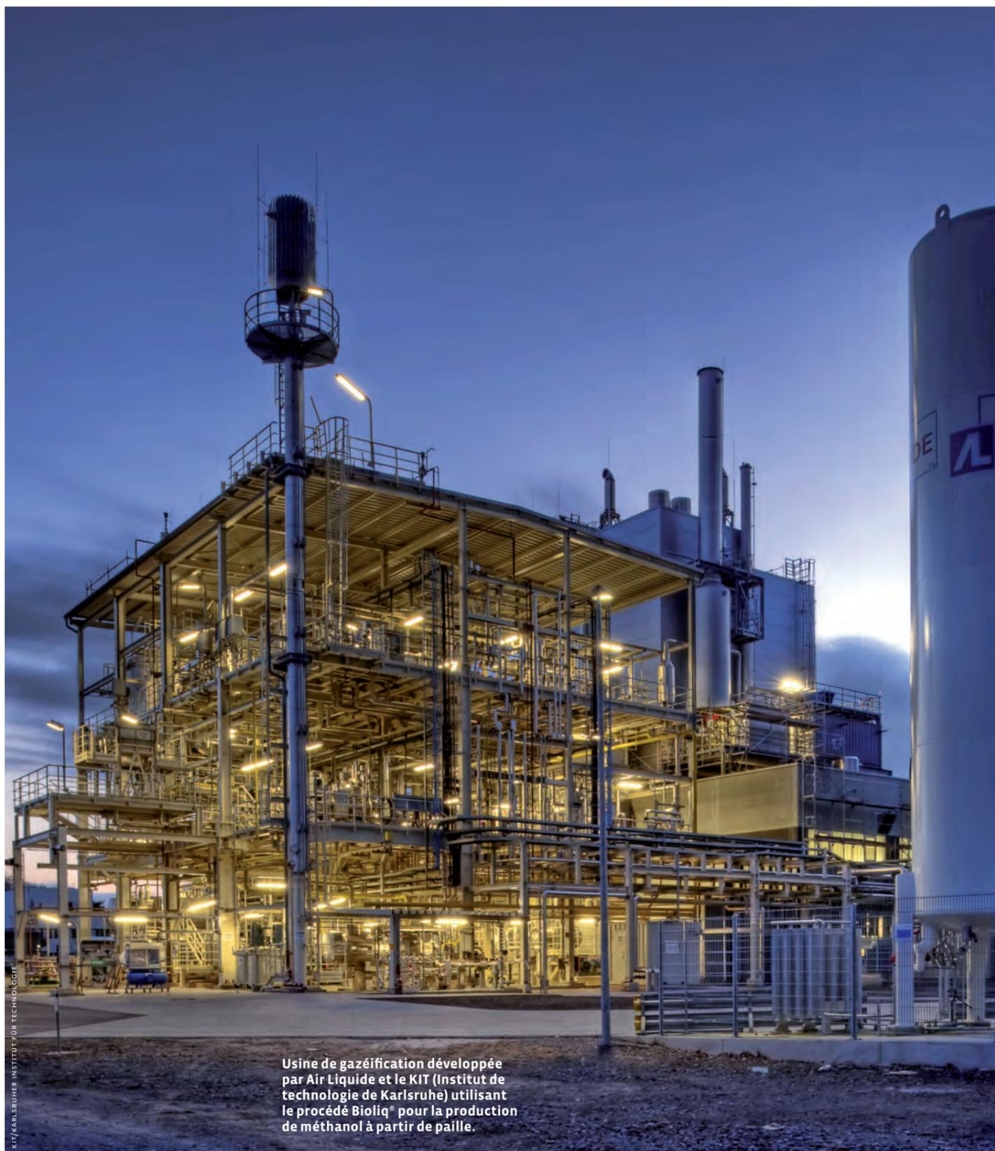
Usine de gazéification développée par Air Liquide et le KIT (Institut de technologie de Karlsruhe) utilisant le procédé Bioliq® pour la production de méthanol à partir de paille.
