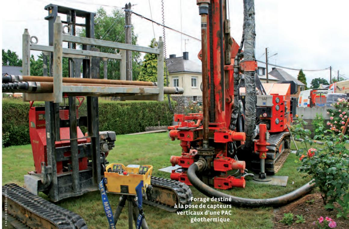
Forage destiné à la pose de capteurs verticaux d'une PAC géothermique.
