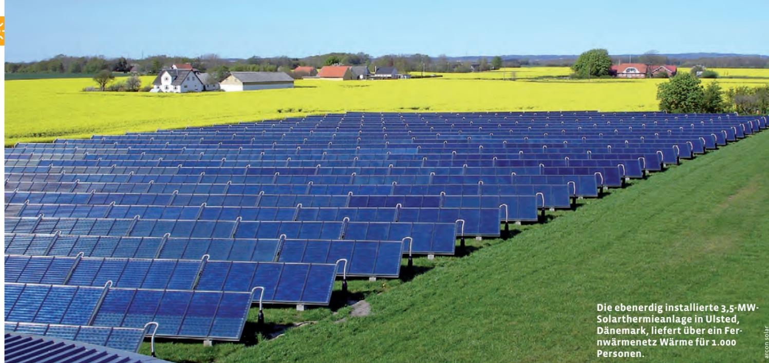
Die ebenerdig installierte 3,5-MW-Solarthermieanlage in Ulsted, Dänemark, liefert über ein Fernwärmenetz Wärme für 1.000 Personen.
