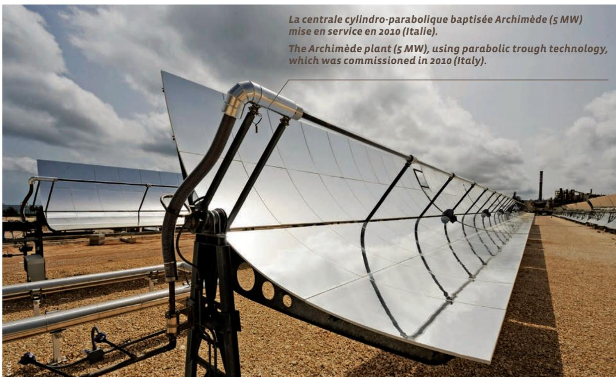
*La centrale cylindro-parabolique baptisée Archimède (5 MW) mise en service en 2010 (Italie).*
